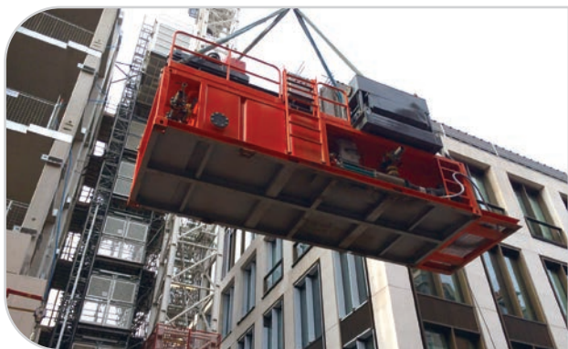
Система регенерации бурового раствора бурения геотермальной скважины
